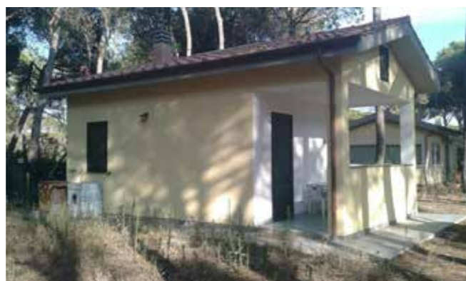
ANNESSE Pineta Marina di Grosseto Realizzazione struttura in cemento armato e tamponatura in laterizio.
