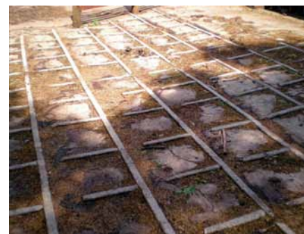
EL PISO DEBE TENER ESTRUCTURAS ANTIDESLIZANTES PARA EVITAR RESBALONES Y CAIDAS
