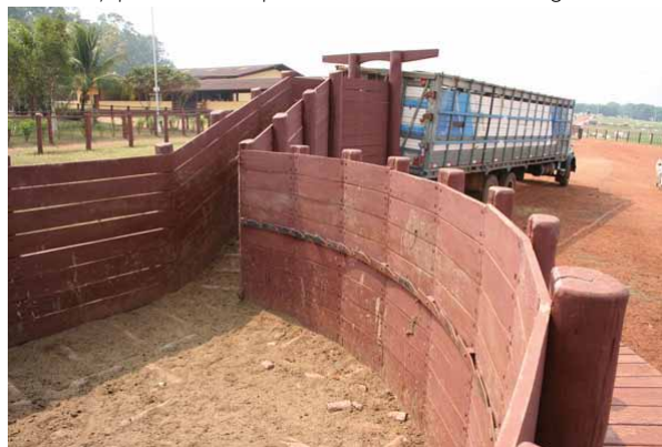
EMBUDO CIRCULAR DE ACCESO AL EMBARCADERO.
