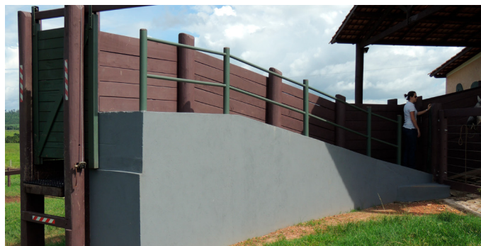
Embarcadouro com paredes laterais fechadas, rampa de embarque com inclinação suave e passarela lateral para realização do manejo.
