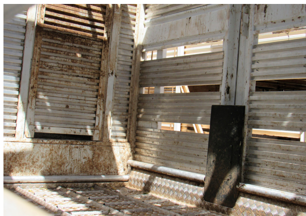
Anteparo protetor no piso do compartimento de carga com plataforma elevatória (elevador).
