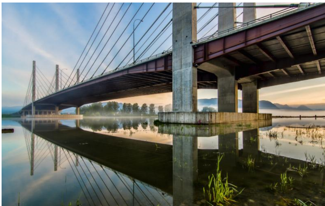
Figura 2 – Emprego de vigas de sustentação em projetos de infraestrutura de grande porte (Pontes)
