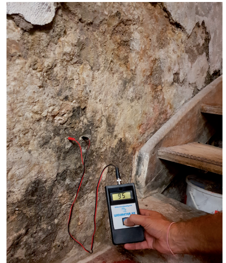
Mit Messungen im Mauerwerk wird der Feuchtigkeitsrückgang festgehalten.
