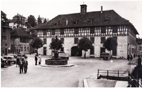
1936 年装修后的大库房，窗户护板和木质桁架成为外观上的明显标志
