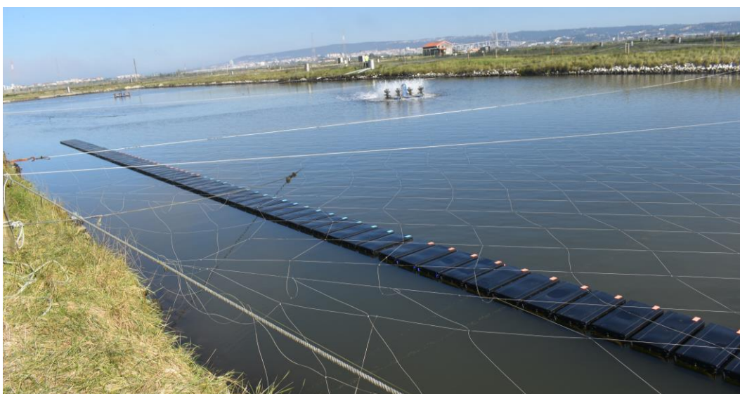
Figura 2: Componentes da estrutura flutuante Ergomarine utilizada neste estudo (em cima) e disposição das 80 unidades no tanque de terra da FFish (em baixo)
