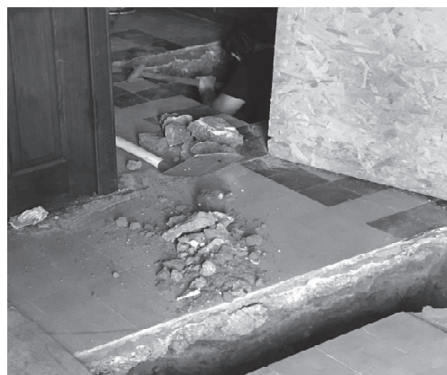
Zie je in het mangat een mannetjesputter? Hij onderzoekt wat nog bruikbaar is van het oude fundament
