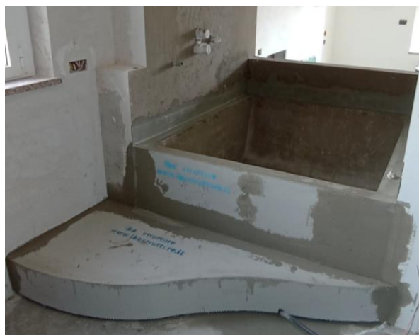
Vasca prefabbricata in XPS, finita e impermeabile, pronta per essere completata con un materiale di rifinitura. Il cliente ha voluto personalizzarla con un gradino esterno e un schienale all'interno.
