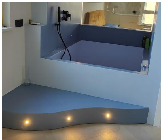
Il cliente ha deciso di rivestirla in microcemento e il suo posatore ha ultimato la personalizzazione utilizzando due colori.
