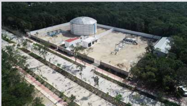
Tanque de almacenamiento y cuadro de bombeo para distribución de agua potable en CIUDAD MAYAKOBA, ubicada en la Riviera Maya.
