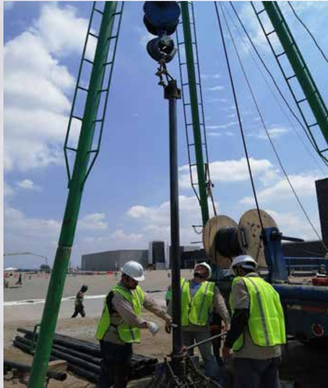
Maniobra de descenso de columna de succión 325m tubería acero cedula 40, 4" de diámetro.
