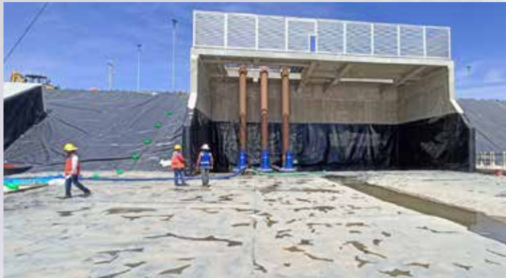
Bombas trasvase de agua pluvial en laguna de captación/aeración.
