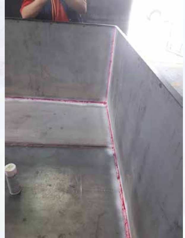
Pruebas realizadas a la soldadura.
