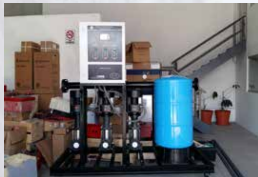
Instalación en sitio por adecuación y actualización de equipo hidroneumático
