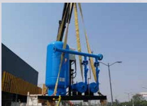
Entrega en obra y maniobra de posicionamiento de equipo integrado.
