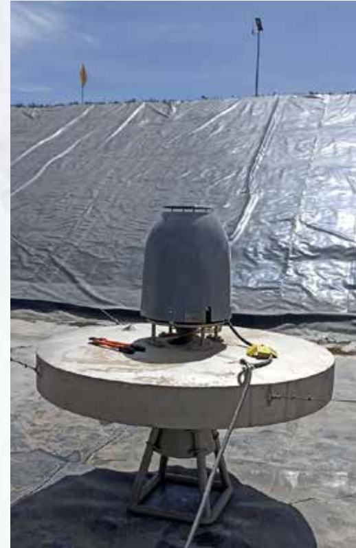
Montaje de aerador y cubierta de motor.
