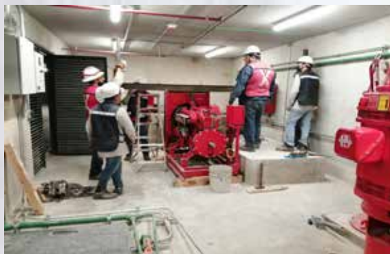
Instalación de motor diesel en cuarto de bombas.
