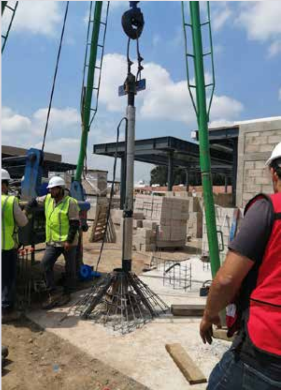
Instalación de bombas pozo profundo.
