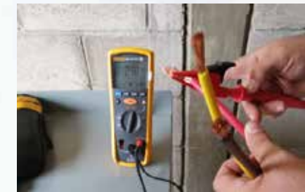
Ensamble de tren de válvulas. Prueba continuidad alimentación eléctrica.
