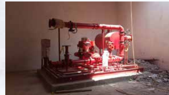
Equipo colocado en punto de operación. Maniobras de descenso en carcamo seco.
