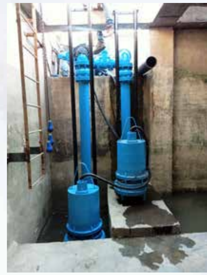
Montaje sistema de izaje.
