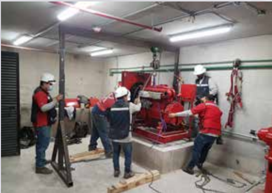
Instalación de motor para bomba multietapas en edificio de altura.
