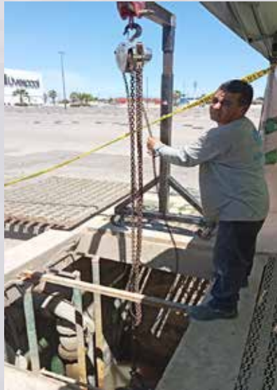
Extracción de bombas.
