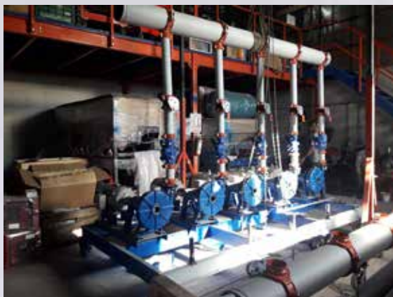
Quintuplex en proceso de fabricación.
