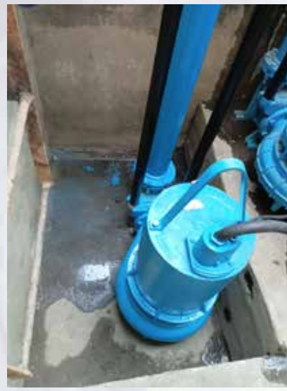
Limpieza de cárcamo.
