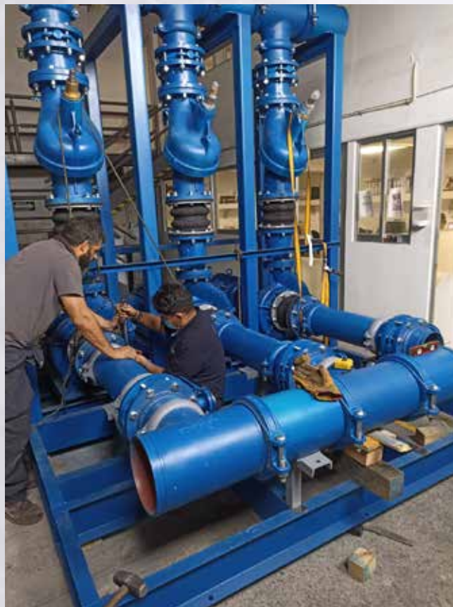
Ensamble de equipo triplex con cabezales de 10"
