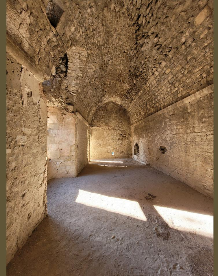
Les voûtes abimées par le temps, l'humidité et les infiltrations d'eau, présentent un important risque pour la structure du château, elles seront restaurées pour sécuriser l'édifice et accueillir le public dans les salles
