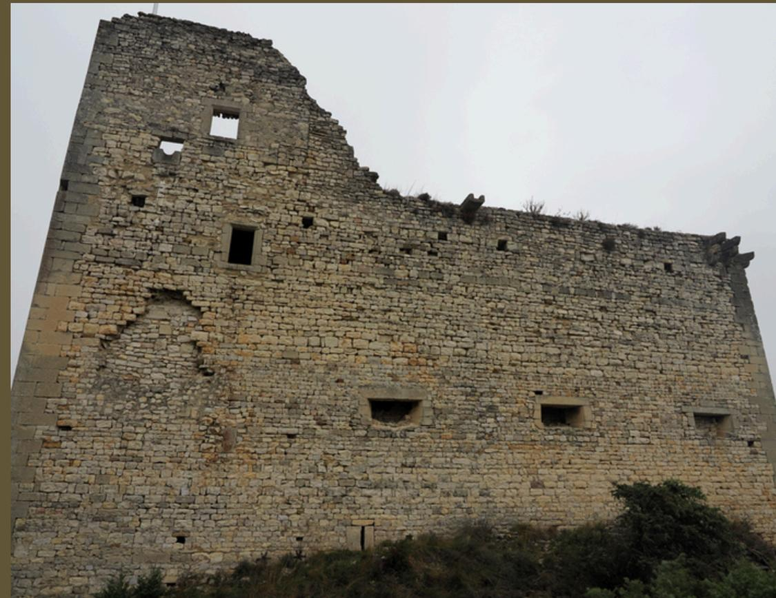
Les façades du château sont dans un état préoccupant : fissures, pierres instables et signes visibles de dégradation. Cette situation représente un réel danger, avec un risque de chutes de matériaux.
