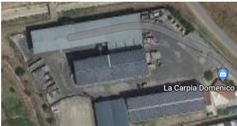
Figura 2: Foto satellitare area impianto (fonte Google Earth)
