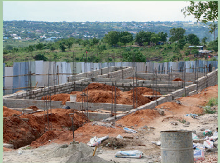
Die Grundmauern werden sehr solide hergestellt.
