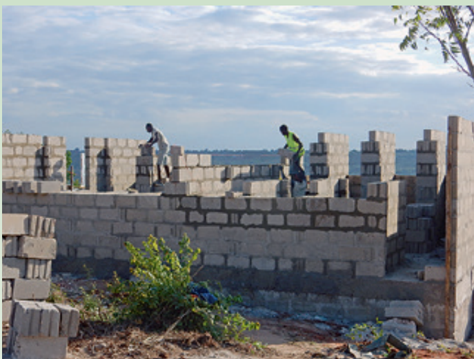
Bau der Toilettenanlage mit biologischer Klärgrube: Jeder Stein wird ohne Hilfsmittel an Ort und Stelle gebracht.
