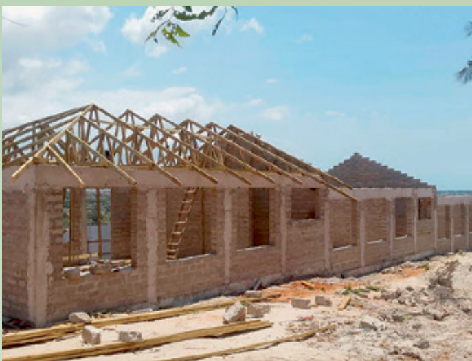
Das Gebäude wird dem Gelände angepasst. Nach jedem Klassenzimmer führen fünf Stufen zum nächsten Niveau.
