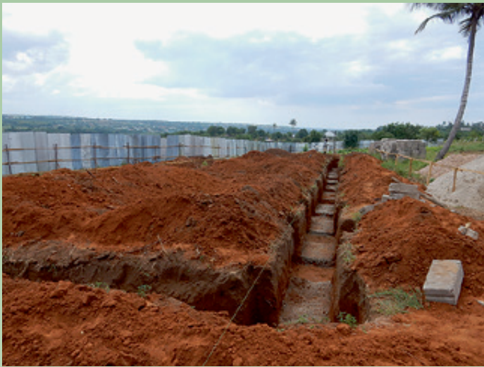
Aushub für das Fundament der Klassenzimmer für unsere Berufsschule, alles Handarbeit.
