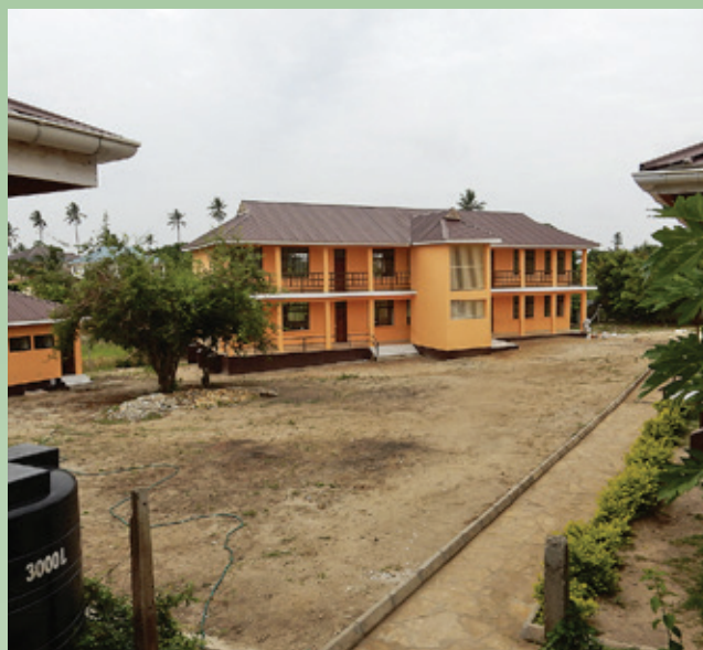
Unser erstes zweistöckiges Schulgebäude erlaubt uns, weitere Klassen doppelt zu führen. Im 2016 beherbergen wir hier temporär die Berufsschulklassen der Schneider- und Gärtnerlehre.
