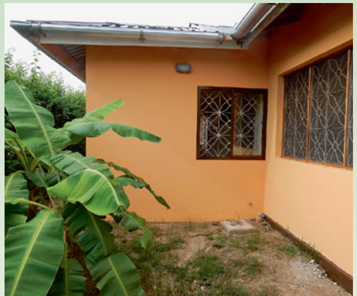
Gelungener Anbau an das Kindergartengebäude: Toilette, Dusche und Wickelplatz für die Kindertagesstätte.
