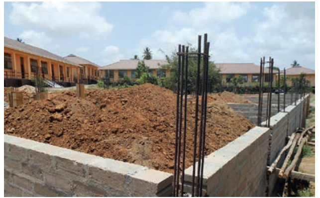
Im Januar begannen wir mit dem Bau des neuen zweistöckigen Schulhauses mit sechs Klassenzimmer.
