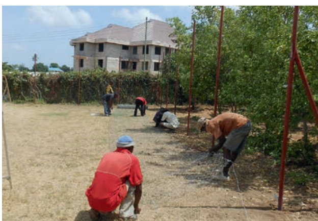
Ein drei Meter hoher Ballfänger wird um unseren Sportplatz erstellt. Endlich werden unsere Fussbälle länger unbeschädigt bleiben.
