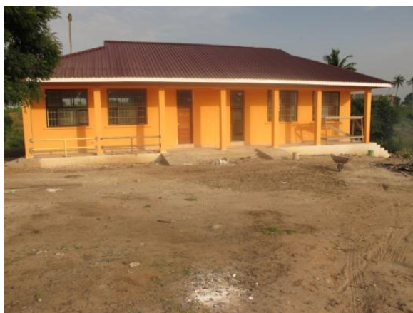
April 2012: Frontansicht des Schulgebäudes mit den zwei neuen Klassenzimmern.
