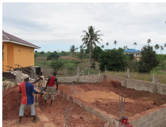
Die Bauarbeiten für die weiteren Schulgebäude haben im April 2012 begonnen.
