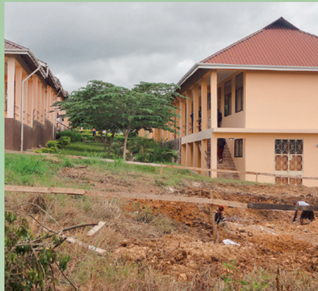
Mitte April erfolgte der Spatenstich für das fünfte Gebäude der Berufsschule.
