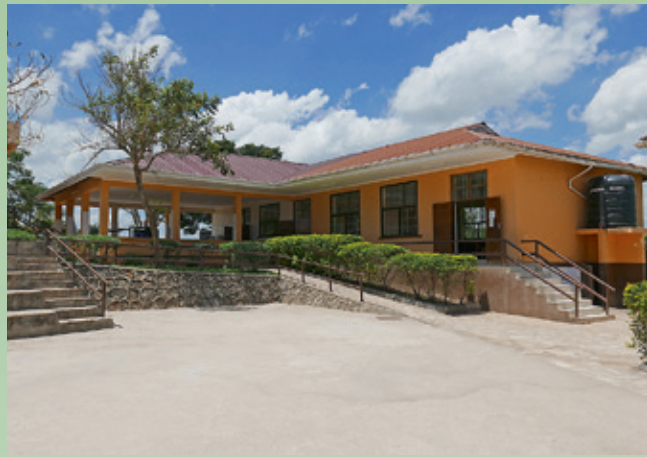
Während der Schulschliessung realisierten wir die Erweiterung des Speisesaals. Zugleich konnten wir lokalen Tagelöhnern in dieser schwierigen Zeit Arbeit ermöglichen.
