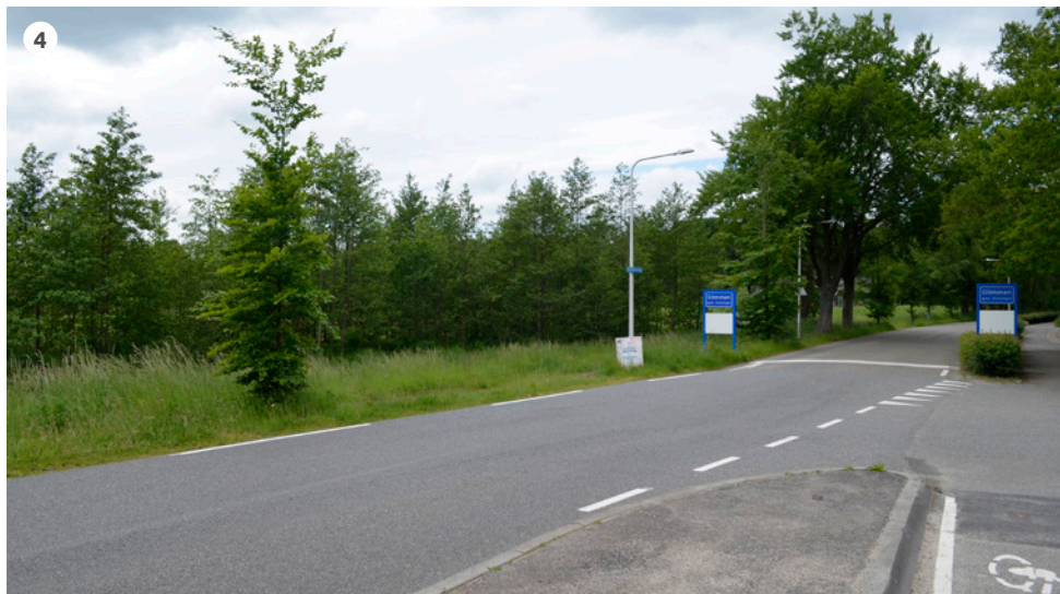
4 Langs de Zuidlaarderweg staat een rij beuken, er ontbreekt er echter één, deze wordt aangevuld.
