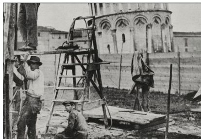
Lavori di restauro alla base della Torre Pendente, 1928 / Restoration work at the base of the Leaning Tower, 1928.
