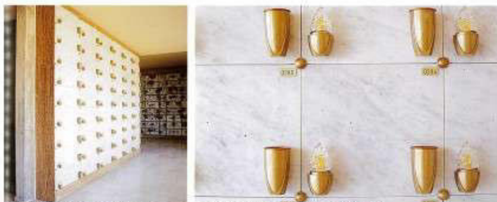
Foto n°2. Esempio di realizzazione di cinerari e ossari con metodologia prefabbricata.
