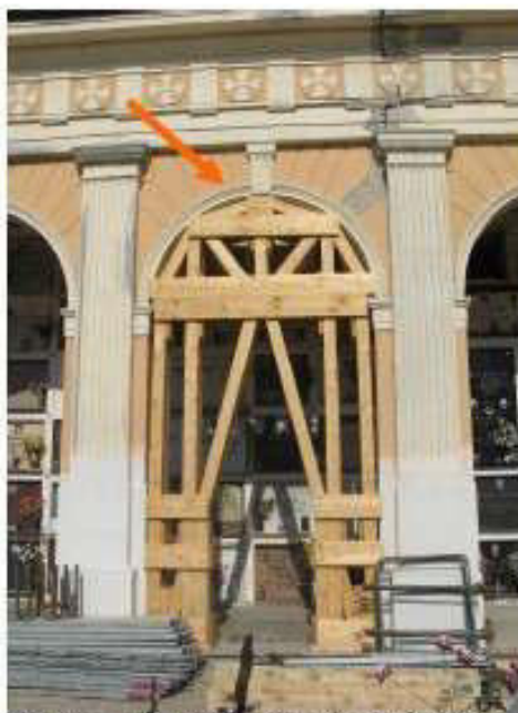
Foto 1 a , 1b. Esempi azioni di consolidamento provvisorio su manufatti cimiteriali che necessitano di interventi strutturali e di restauro definitivi
