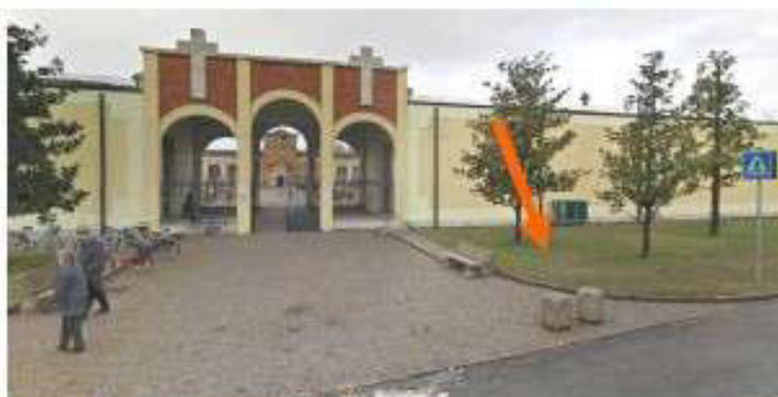
Foto n°9a. Vista dell'area di intervento le frecce indicano l'area interessata dagli interventi.
