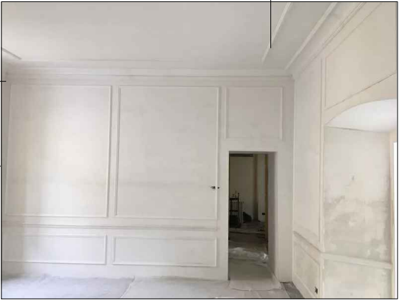
cornice alta 14/16 cm perimetro
