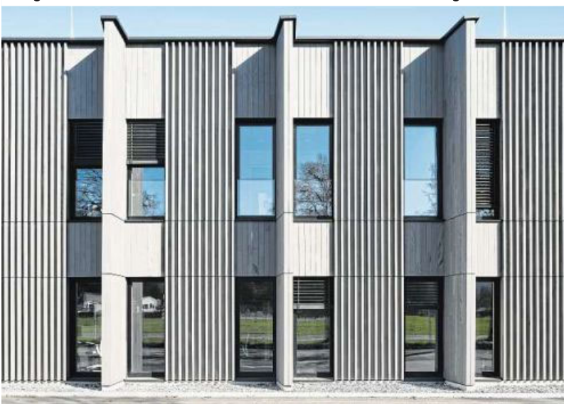
Vertikale Holzscheiben wirken als Sonnen- und Blendschutz.
