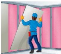
8.- Es importante que el material se expanda completamente para obtener el aislamiento apropiado. La barrera de vapor, en caso de ser necesario, debe ir hacia el área más cálida en invierno.
