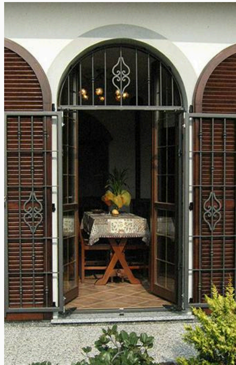
Sbalzo aperto verso l'esterno
