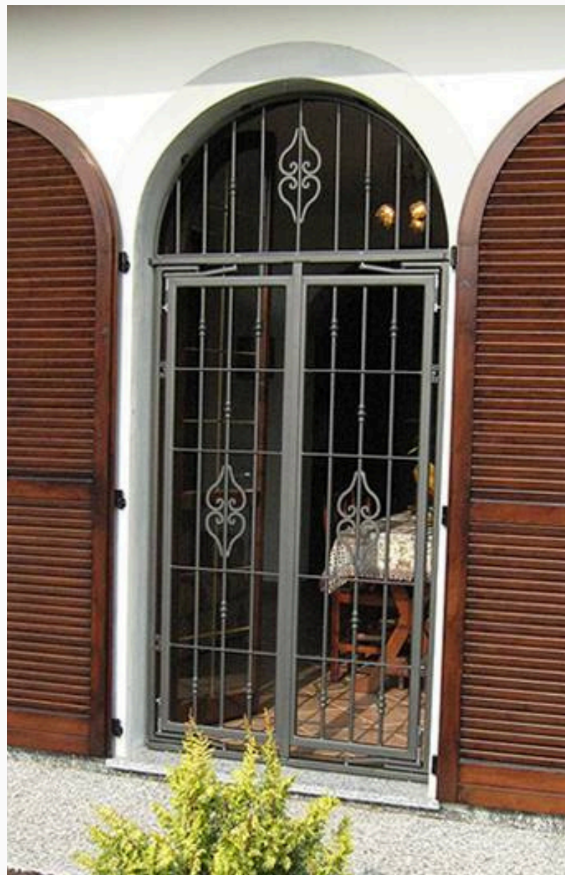
Sbalzo su portafinestra
