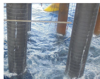
Bescherming van stalen pijlers ALLTER systeem
