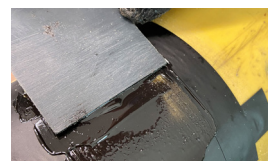
KEBU PU Repair
