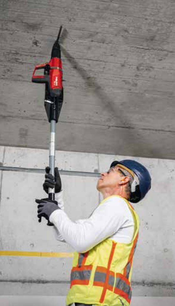
DECKE. Bohren gehört vielleicht schon bald nicht mehr zwingend zum Standard.
