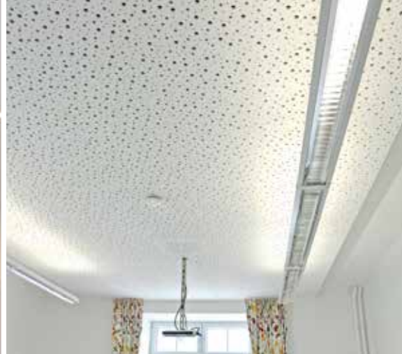
AUSBLICK. Im angrenzenden Raum ist die baugleiche Decke noch im Originalzustand – auch hier ist eine Sanierung nach dem erfolgreichen Vorbild geplant.
