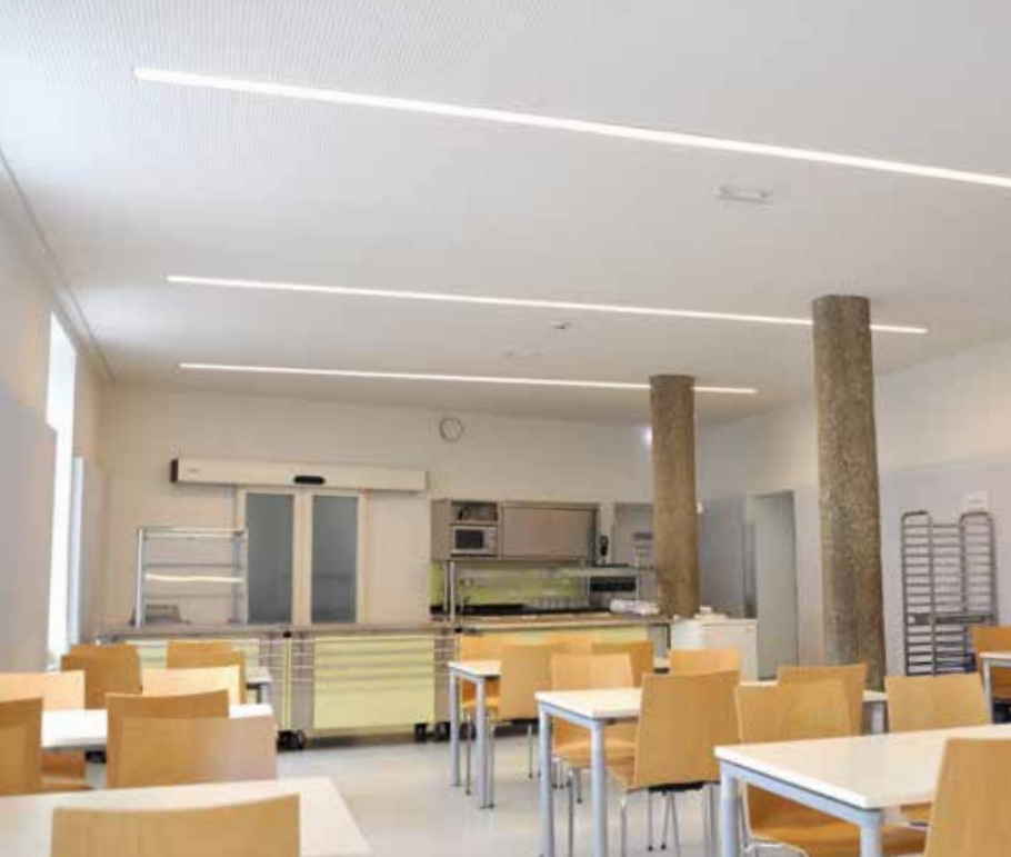
MONTAGE. Die Weitspannträgerdecke wurde präzise unter der Altdecke befestigt – Grundlage für die moderne, akustisch wirksame Lochplattendecke.
