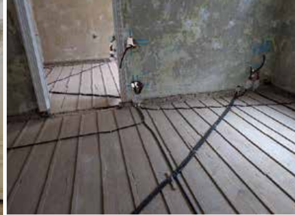
STEP 2/ELEKTRIKER. Am Rohboden werden alle Leitungen laut Plan verlegt und befestigt.
