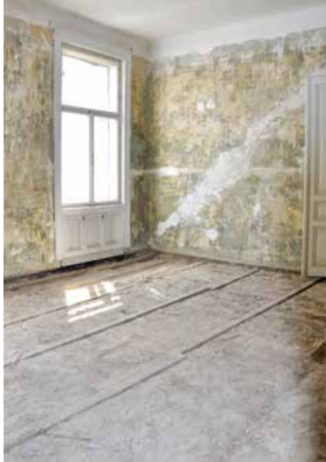
STEP 1/RÜCKBAU. Schicht für Schicht wurde der alte Bodenaufbau entfernt. Der Bauherr legte selbst Hand an, um den Bestand genau kennenzulernen und mögliche Überraschungen frühzeitig auszuschließen.
