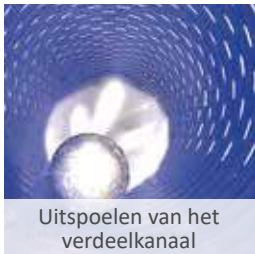
Camera-inspectie van het verdeelkanaal
