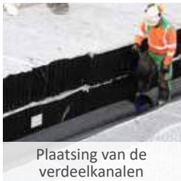
Uitvoering van sleuven voor verdeelkanalen
