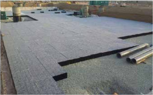
NIDAPLAST EP-OPSLAGBEKKEN Jeddah (ARS) – 16.000 m 3
