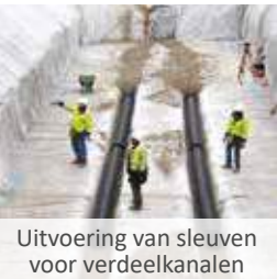
Plaatsing van de verdeelkanalen
