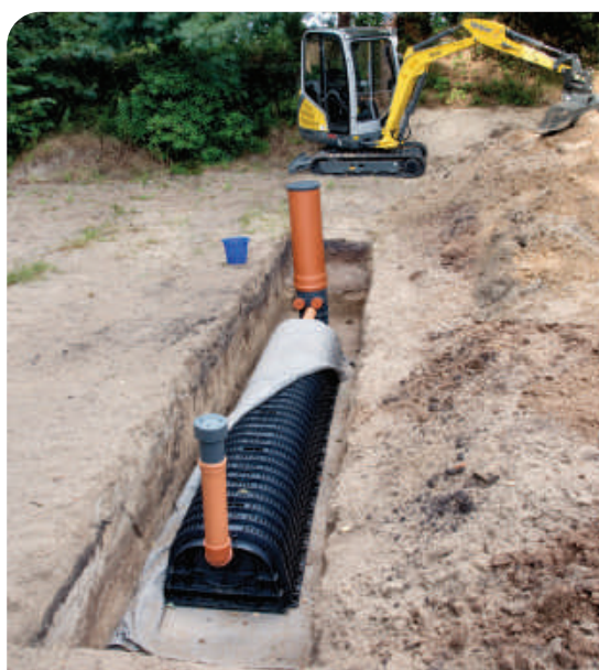
Die Verfüllung erfolgt mit Sand
