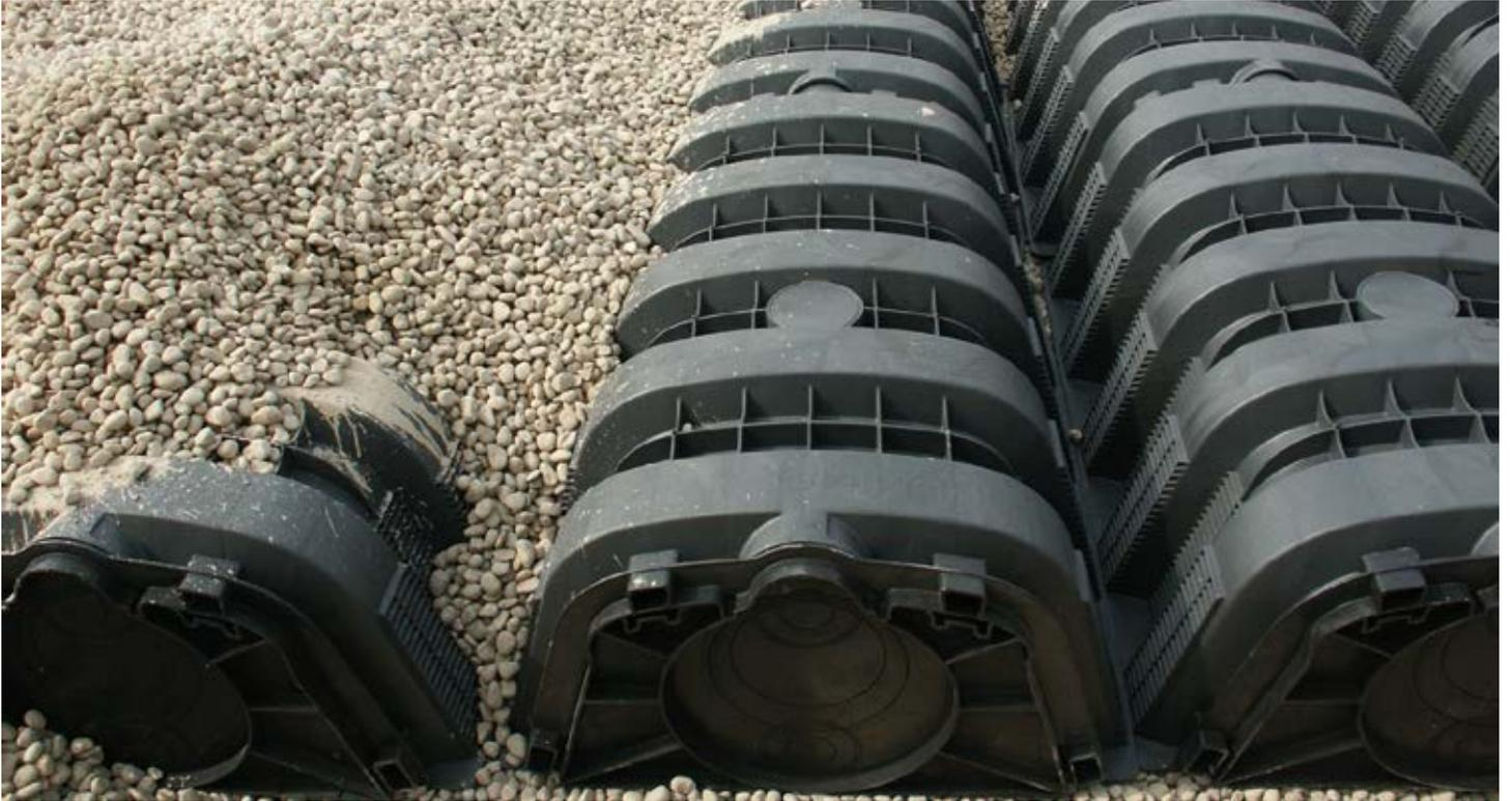
DRENING ist ein modulares Element aus HD PE, das zur Errichtung von eingegrabenen Becken entwickelt wurde, um Regenwasser direkt vor Ort abzuleiten. Je nach Installationsart kann DRENING die Wiederverwendung des gesammelten Wassers oder die Drainage im Untergrund begünstigen und dabei der Überschwemmung von Oberflächen vorbeugen und zur Befüllung von Grundwasserleitern beitragen. So können Wasserressourcen gespart werden.
