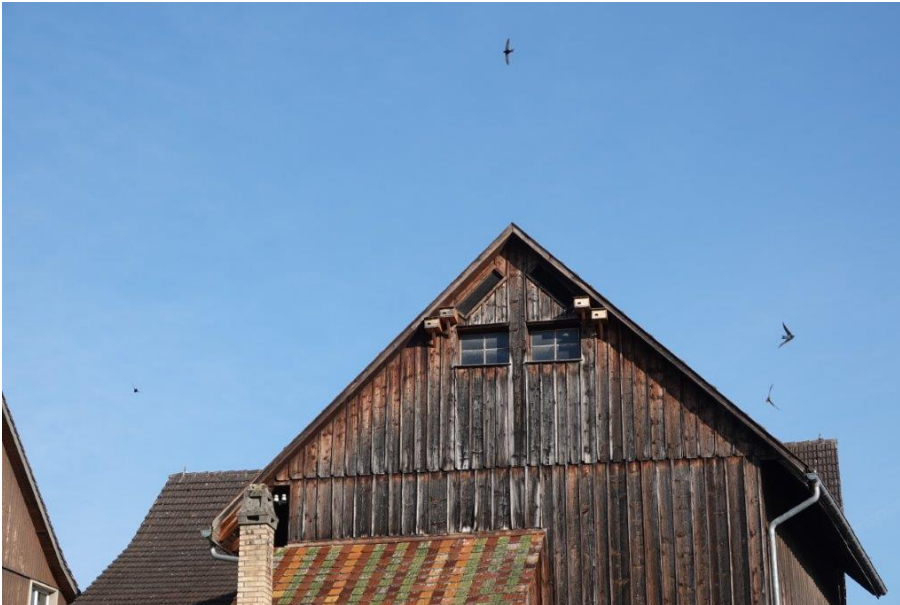
Mauerseglernistkästen, Zürcherstrasse 25, Ostseite, von Haussperlingen belegt.
