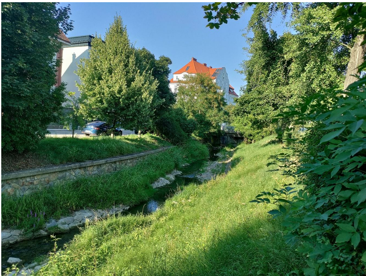
Kierlingbach direkt an der Mühlengasse
