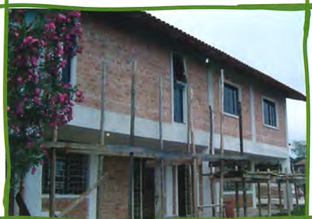
Bau der Schule
