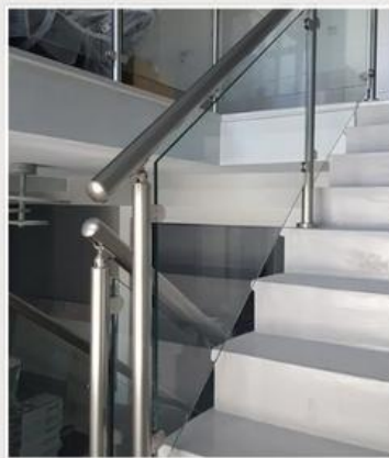
Barandales y pasamanos
