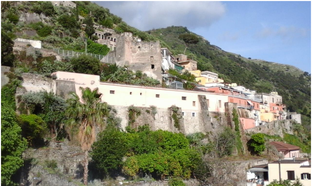
Facciata sud dell'ex complesso di S. Domenico
