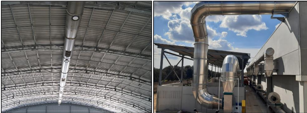
Figura 5: Sistema di aspirazione aria esausta
