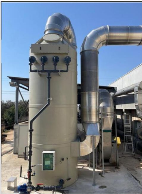
Figura 14: Capannone di Maturazione e annesso sistema di trattamento dell'aria
