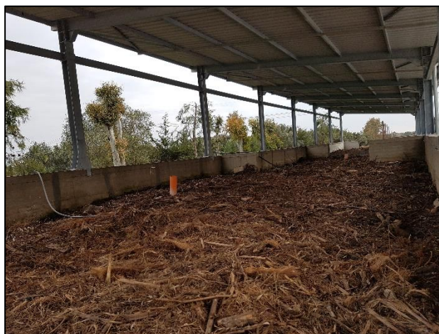
Figura 7: Biofiltro
