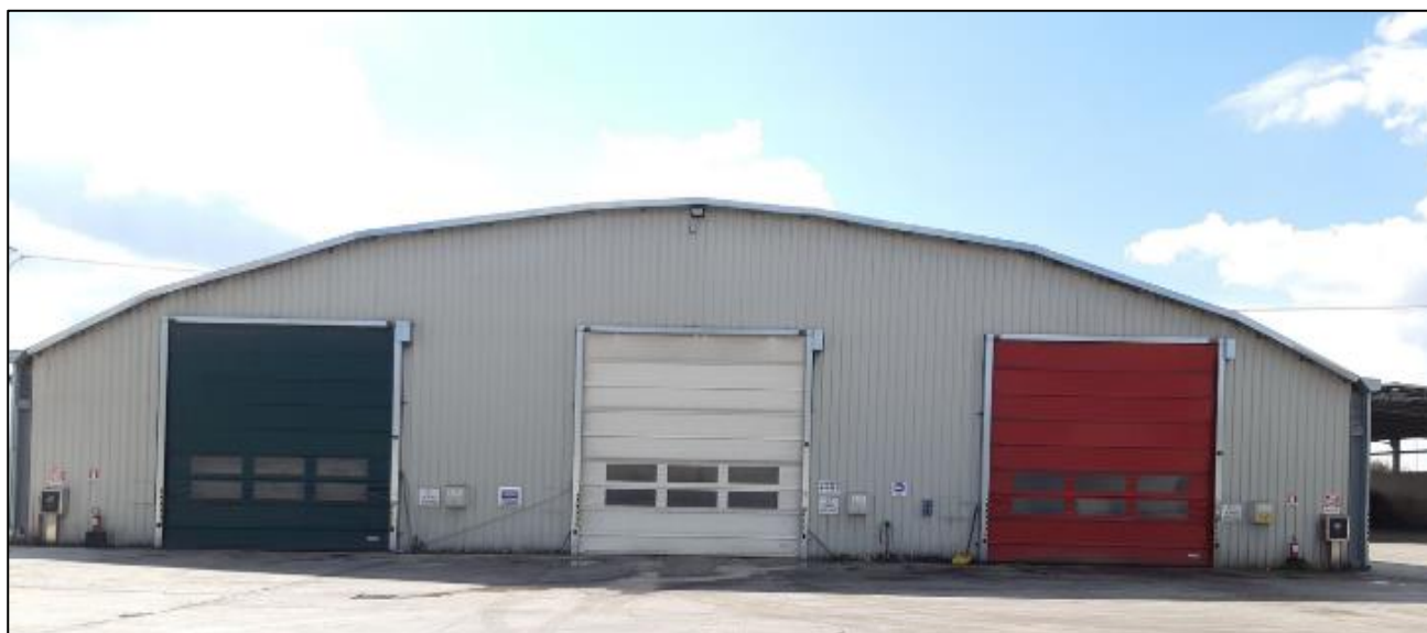
Figura 2: Capannone ricezione e pretrattamento rifiuti
