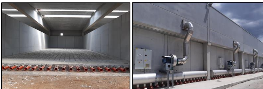
Figura 11: Sistema di insufflazione di aria
