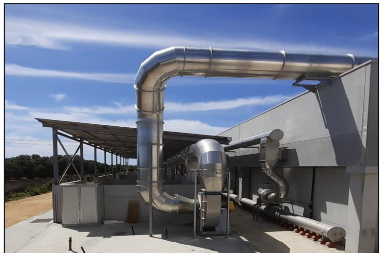
Figura 14: Capannone di Maturazione e annesso sistema di trattamento dell'aria
