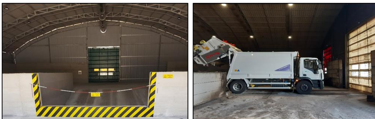
Figura 3: Capannone ricezione e pretrattamento (vista interna)
