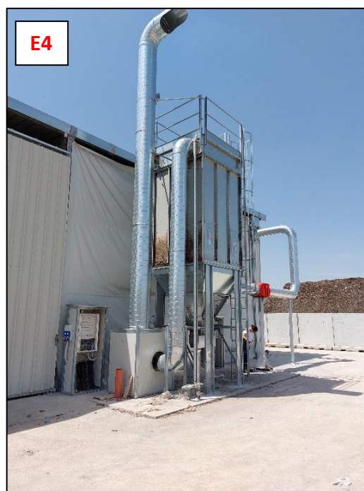
Figura 16: Filtra a manica, per il trattamento dell'aria durante la vagliatura
