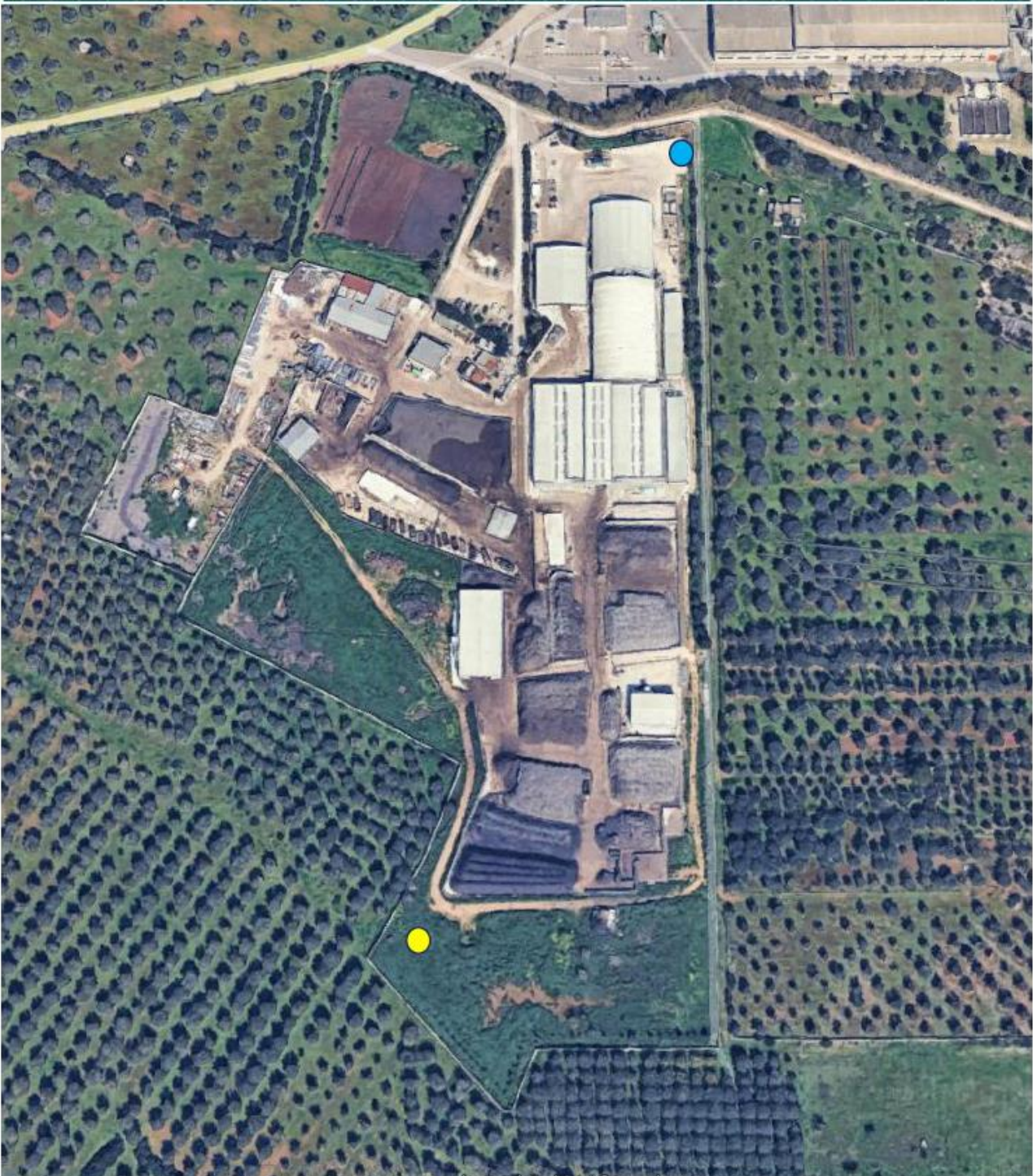
Figura 21: Localizzazione del sistema di monitoraggio in continuo
