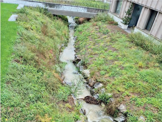
Die Bachgestaltung im Bereich Otmarhof ist abgeschlossen. Im Spätherbst werden noch weitere Bepflanzungen folgen.
