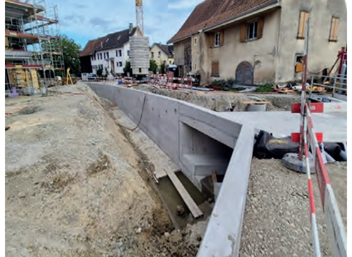
Entlang der Unterdorf- und Wiesenstrasse sind die Betonarbeiten der Stützmauer und Brücke abgeschlossen. Der Belageinbau der Wiesenstrasse wird Anfang Oktober erfolgen sowie die Anpassungen an der Unterdorfstrasse. Bis Ende Jahr wird das Bachbett durch den Wasserbauer erstellt und die Mauer mit einem Geländer versehen.
