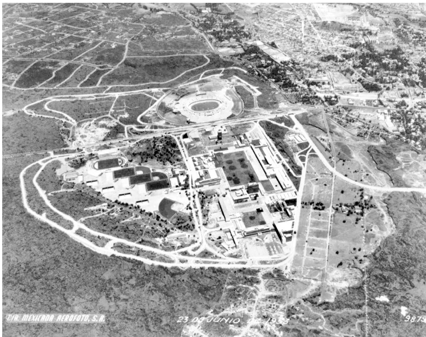
Vista aérea del campus central de Ciudad Universitaria, UNAM, 23 de junio de 1953. Imagen que documenta la configuración inicial del conjunto, donde se reconoce la organización del trazo urbano, la implantación de los edificios y su adaptación al paisaje volcánico del Pedregal de San Ángel.
