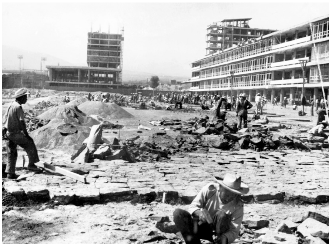
Explanada del Campus Central de Ciudad Universitaria, UNAM, en construcción, 1951-54. La imagen muestra a trabajadores durante las obras, evidenciando la transformación del terreno volcánico y el levantamiento de las primeras estructuras del conjunto.
