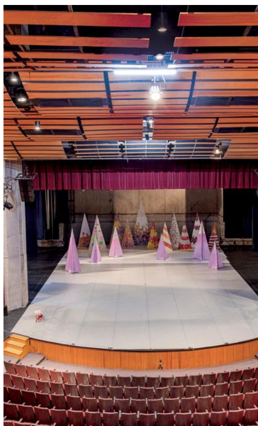
Las instalaciones con que cuenta la Sala Miguel Covarrubias, permiten la colocación de múltiples "varas de luces", que sujetan una gran diversidad de iluminación en escena.
