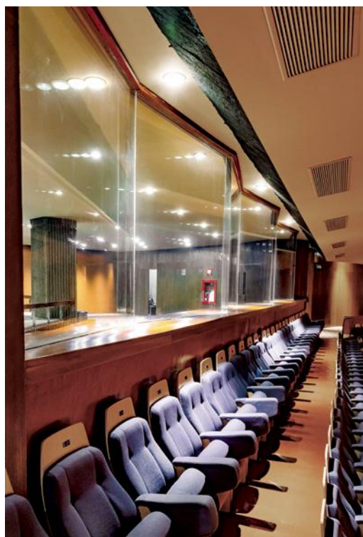
Otros elementos visualmente claros son las cámaras de cristales creados con dos láminas de cristal que dividen el vestíbulo superior de la sala y son colocados en forma de zigzag, igualmente diseñados para la óptima transmisión del sonido.
