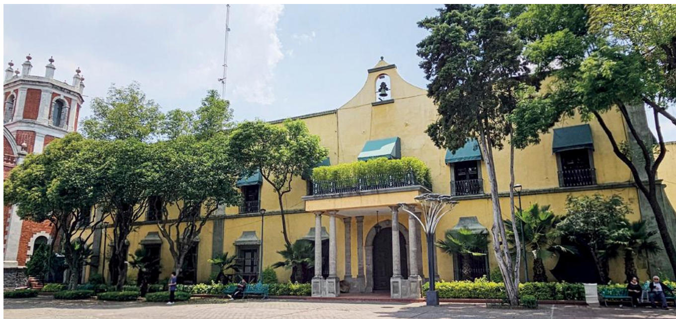
La Casa Amarilla, actual edificio de gobierno de la alcaldía Miguel Hidalgo. En su origen funcionó como convento franciscano.
