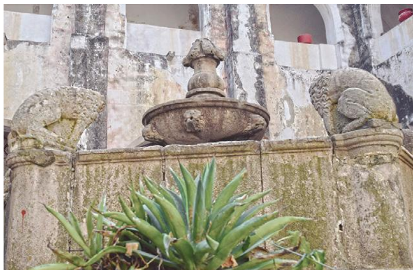
Fuente de los leones. Fuente: ocuituco.gob.mx
