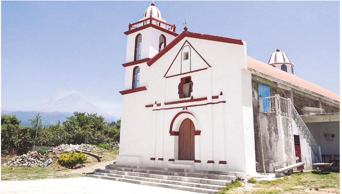
Iglesia de la localidad de Ocoaltepec, en el municipio de Ocuilco. Foto: ocuilco.gob.mx
