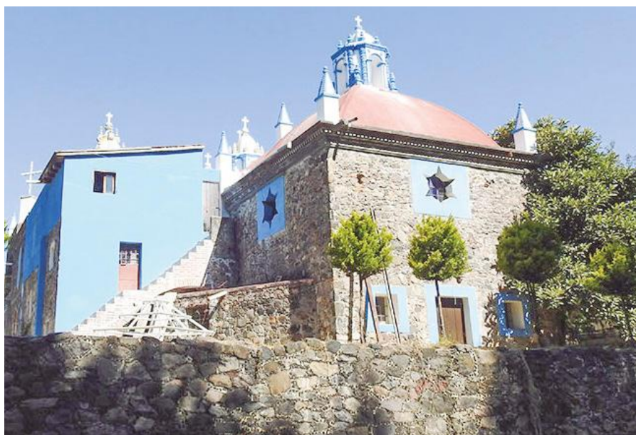
Iglesia de la localidad de Jumiltepec, en el municipio de Ocuilco. Foto: ocuilco.gob.mx
