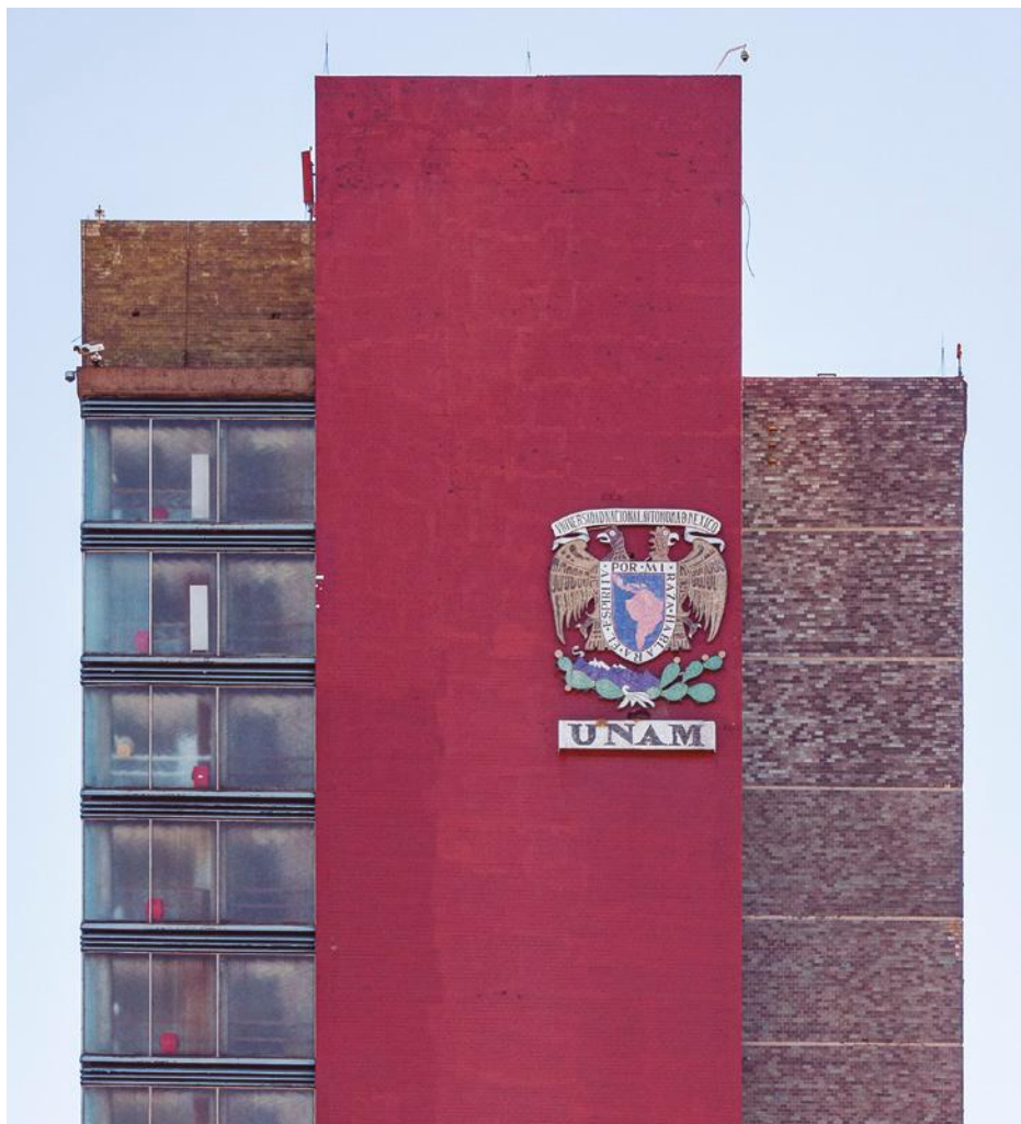
Vista de la fachada principal de la torre de Rectoría, que porta el escudo de la UNAM en su parte más alta. Foto Armando Méndez
