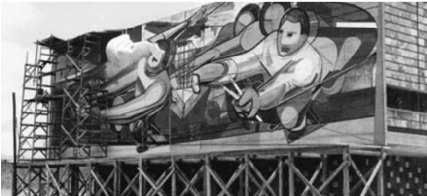
Proceso de construcción del mural de Siqueiros " El pueblo a la Universidad, la Universidad al pueblo " Foto. IISUE-AHUNAM/DOC 3408. Tomada de http://www.comitedeanalisis.unam.mx/fhistoricas.html
