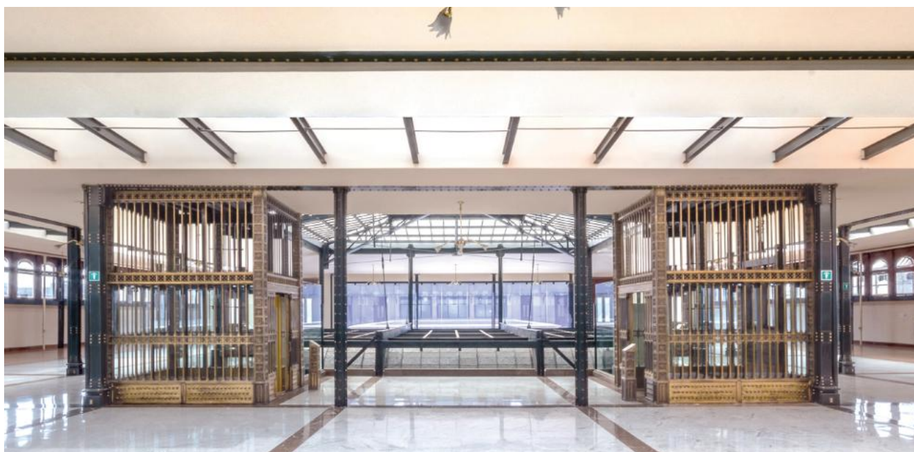
Entre las más lamentables agresiones que ha sufrido el Palacio Postal está la demolición de las rejas y estructuras ornamentales de bronce de los elevadores originales
