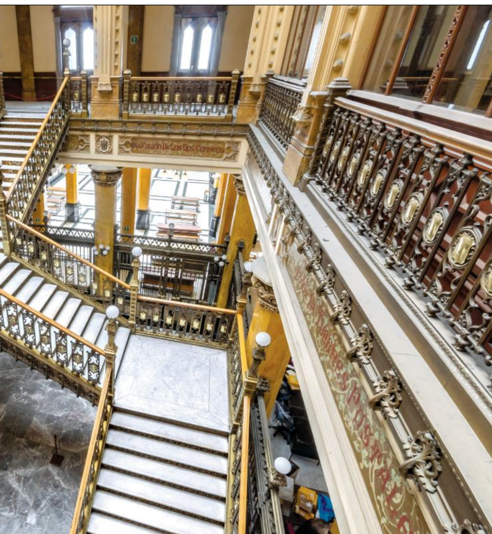
Tomando de base las fotocopias existentes de los planos originales de Boari y los croquis de trabajo del mismo arquitecto, se reintegraron todas sus partes y acabados originales
