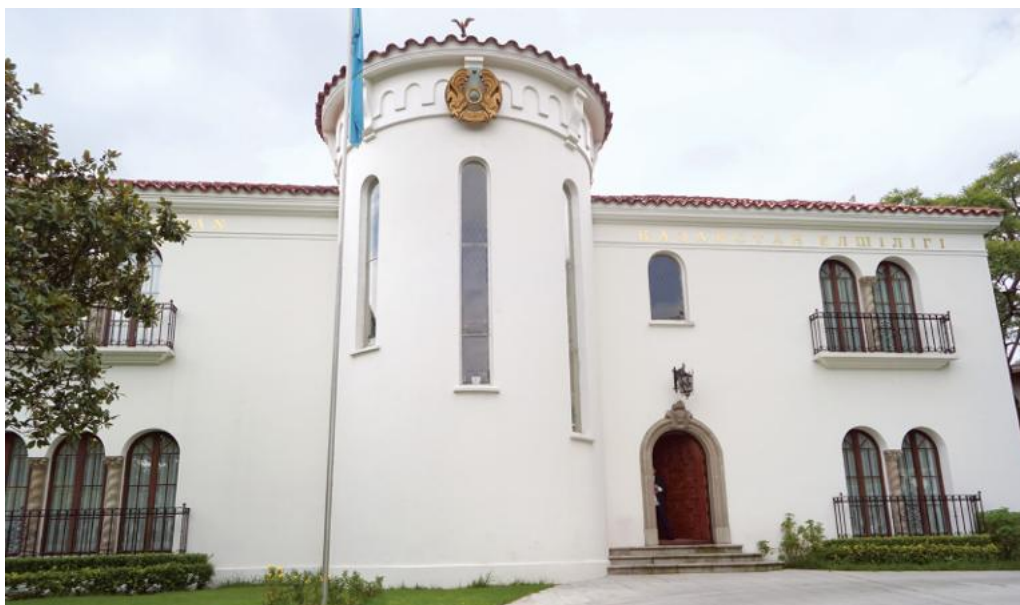
Fachada de la embajada de la República de Kazajstán en México
