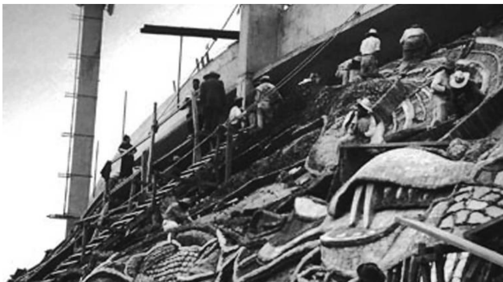
Diego Rivera en la construcción del mural en la fachada del Estadio Olímpico Universitario. Fuente: http://www.fundacionunam.org.mx/donde-paso/sabes-como-se-construyo-ciudad-universitaria/
