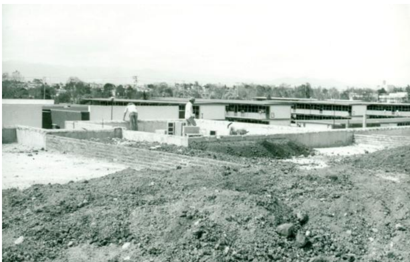
Construcción de los edificios del CCH Vallejo en 1971 Foto: Archivo histórico del CCH
